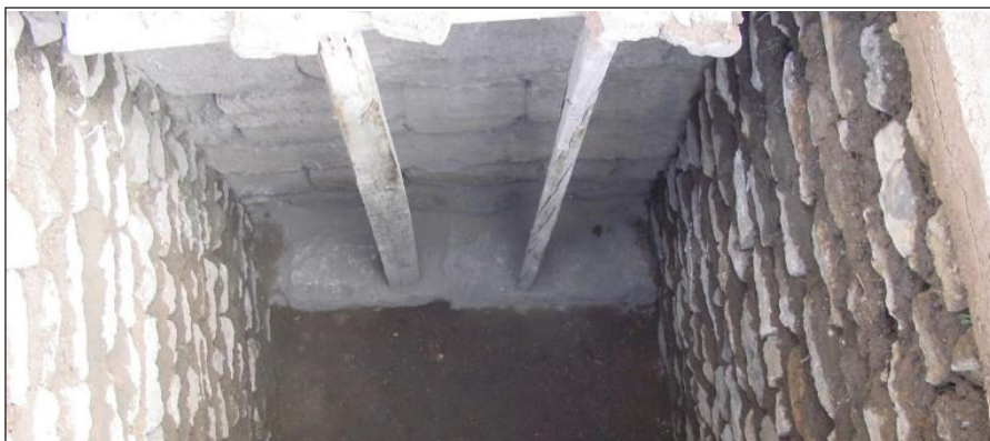
تصویر ۶. چیدمان نمای بخش‌های تحتانی ضلع جنوبی جرز شمالی ایوان از داخل گمانه که عمدتاً به صورت چیدمان راسته ملاحظه می‌شود (عکس از: نویسنده).
