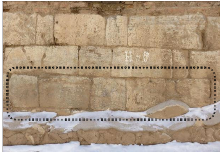
تصویر ۱۱. دقیقاً مشخص نیست قطعات سنگ در لایه مشخص شده از نظر کاربرد کله اند یا راسته (عکس از: نویسنده).
