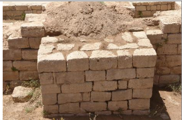
تصاویر ۴ و ۵: تصویر و طرح مربوط به مقطع افقی دیوار یک نمونه از چیدمان راسته به منظور نشان دادن عمق فرورفته سنگ راسته در دل جرز در محل منسوب به محل نگهداری نذورات آتشکده (عکس از: نویسنده).
