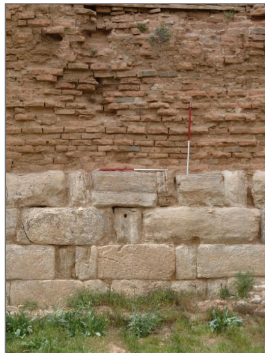
تصویر ۱۵: ترکیب سنگ و آجر در بنای ایوان غربی (عکس از: نویسنده).
