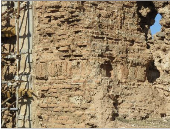
تصویر ۱۸. قرارگیری یک ردیف آجر به صورت عمودی (عکس از: نویسنده).
