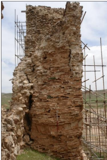
تصویر ۲۱ و ۲۲. نحوه چیدمان و قراگیری لاشه‌سنگ ایلخانی به صورت لایه‌ای بر روی بقایای آجری ساسانی ایوان غربی (عکس از: نویسنده).
