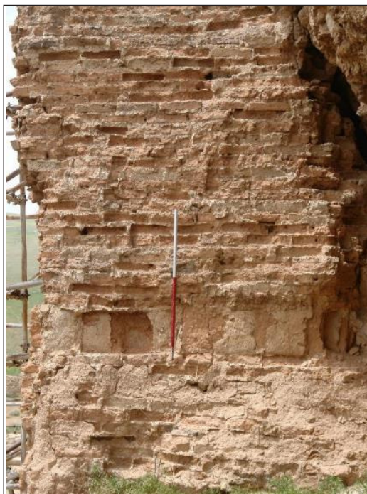
تصویر ۱۶. مقطع عمودی قسمت آجری جرز شمالی و نمایش نحوه چیدمان آجرها (عکس از: نویسنده).
